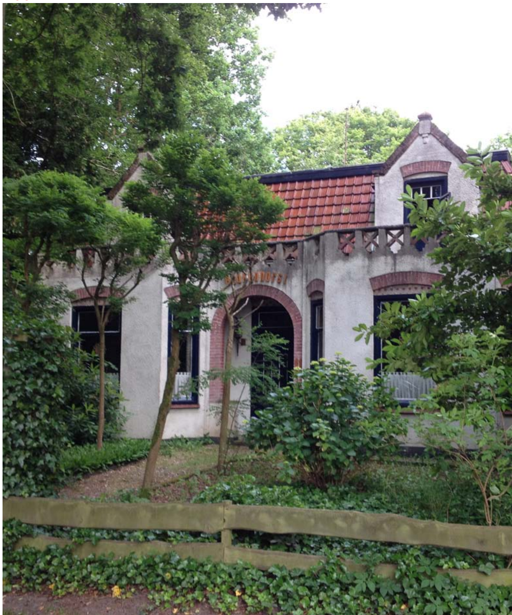
Verbouw en renovatie woonhuis Bergen
