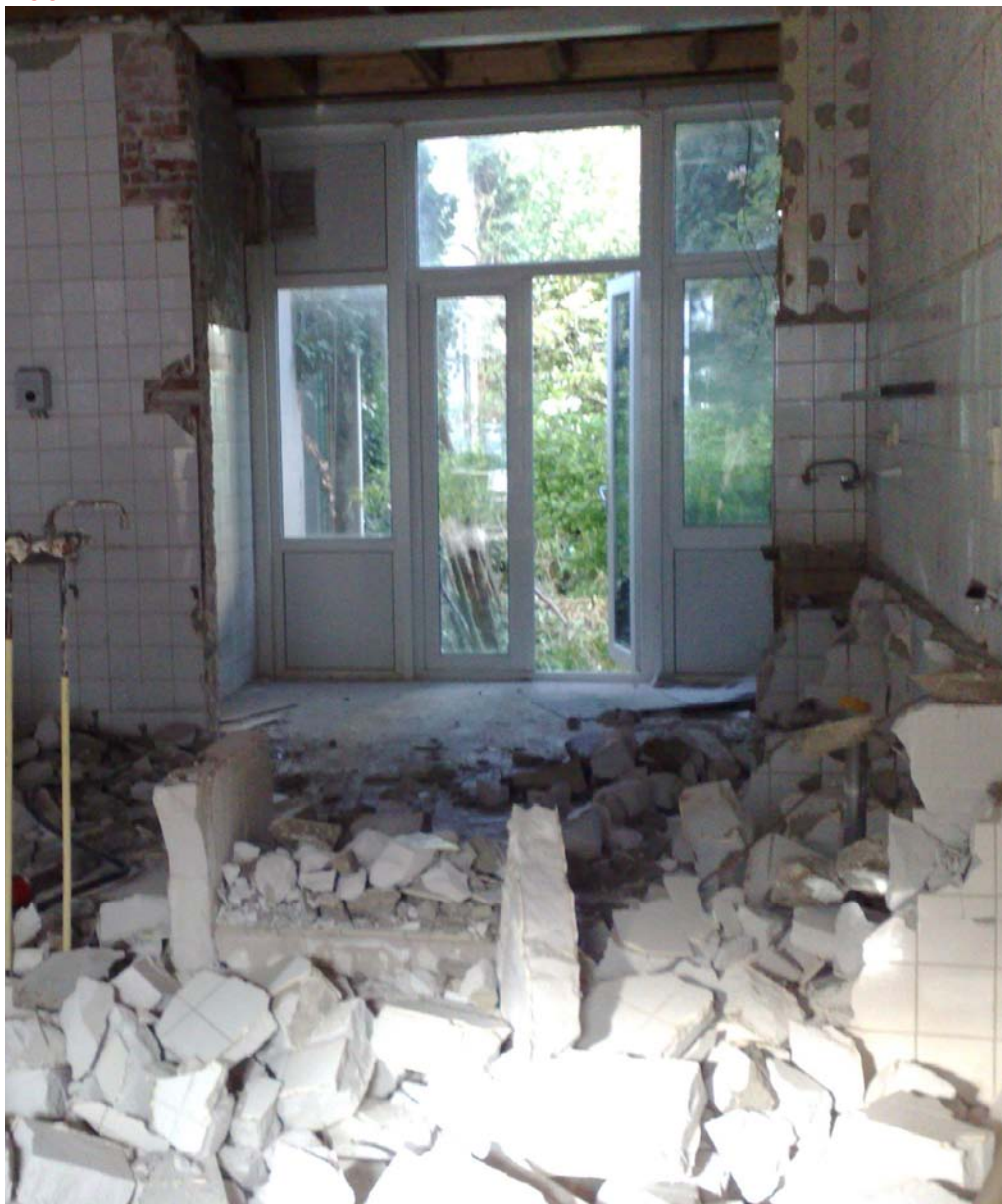
Renovatie woning Rotterdam
